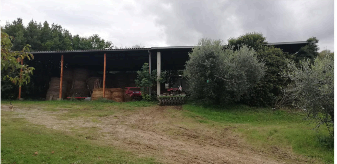
Foto n. 3 - Vista area oggetto di intervento ANTE OPERAM - Comune di Montepulciano
