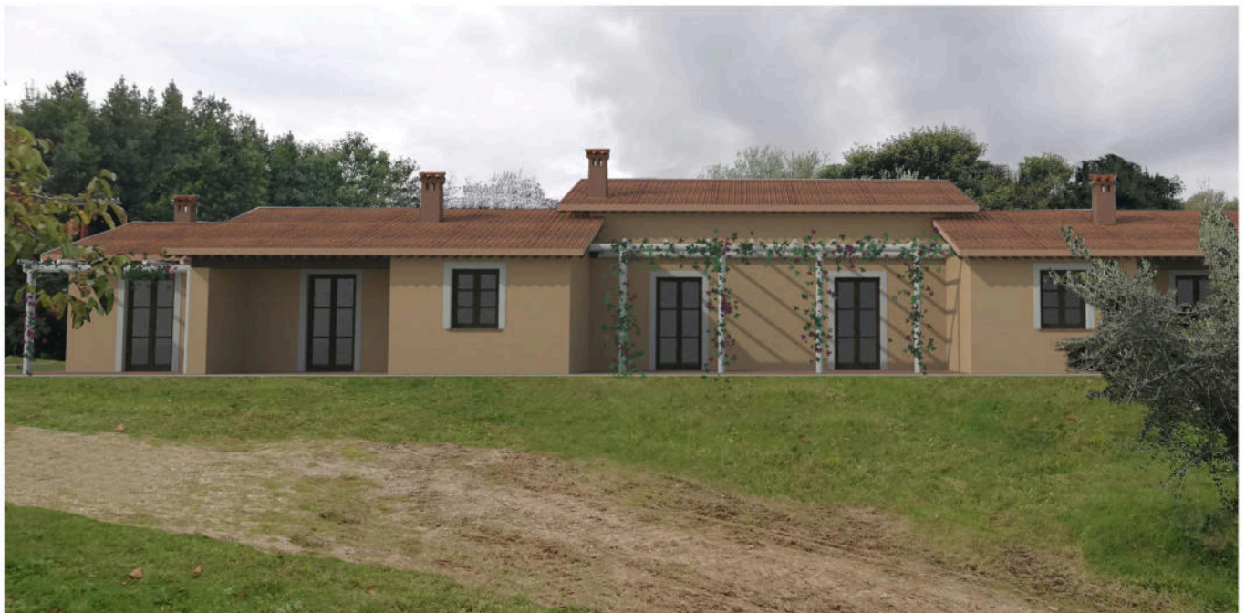
Foto n. 4 - Vista area oggetto di intervento POST OPERAM - Comune di Montepulciano
