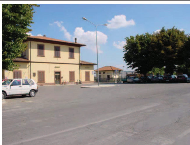
Il piazzale della stazione è caratterizzato dalla scarsa qualità degli spazi pubblici e dalla generale assenza di aree confortevoli per l'attesa del trasporto collettivo.
