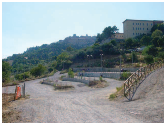
Alcuni ambiti ampi, ma poco accessibili, sono però sottoutilizzati.
