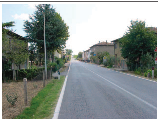
L'assetto rettilineo della strada causa velocità di transito eccessive e rende pericolosi gli attraversamenti pedonali.
