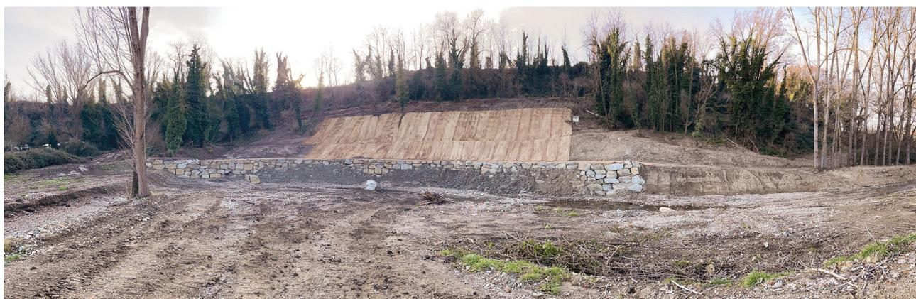
Figura 54: Intervento di consolidamento frana Torrente Castro a protezione del collettore principale in arrivo al depuratore Casolino
