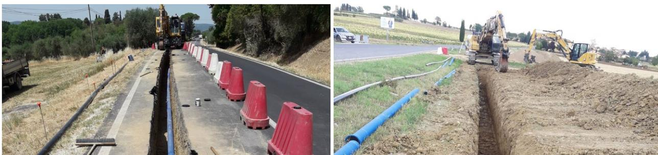
Figure 31 e 32: Lavori di condotte di adduzione/distribuzione da impianto di potabilizzazione Cesa a sollevamento Badicorte e da Badicorte a Loc. Torena
