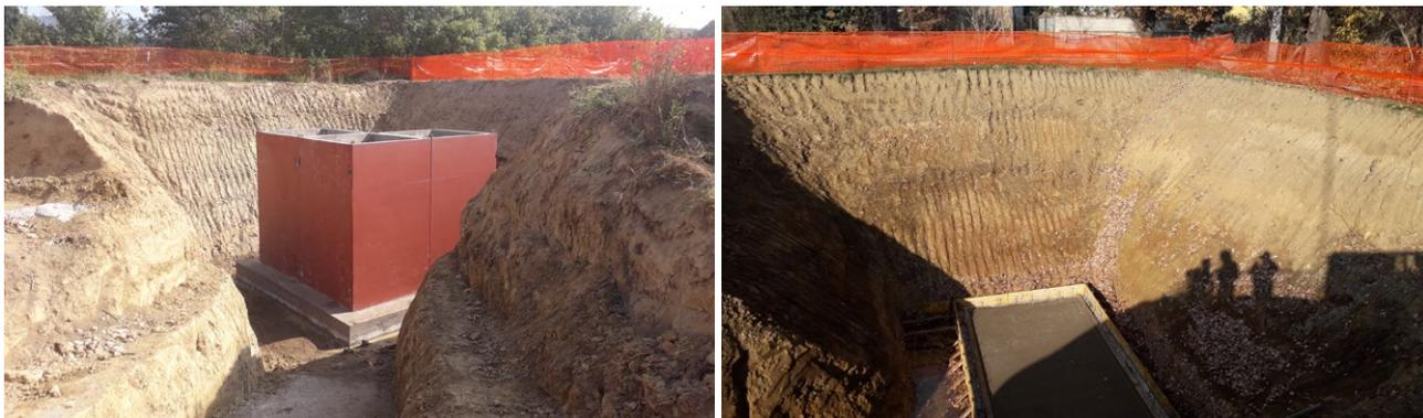
Figure 41 e 42: Posa in opera impianti di sollevamento in Loc. Rigutino
