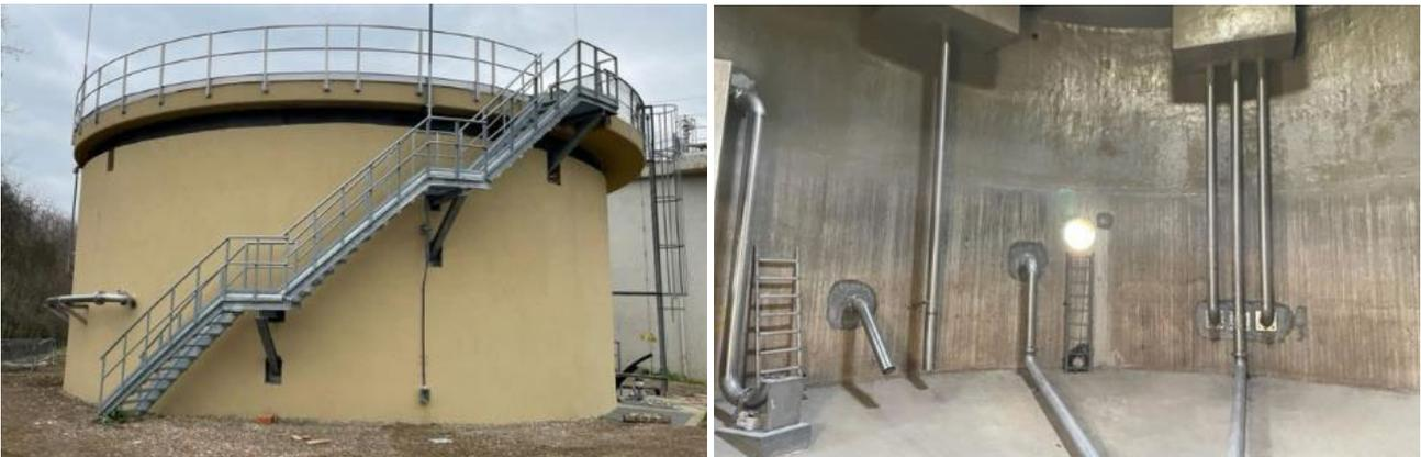
Figure 57 e 58: Digestore anaerobico secondario - lavori conclusi
