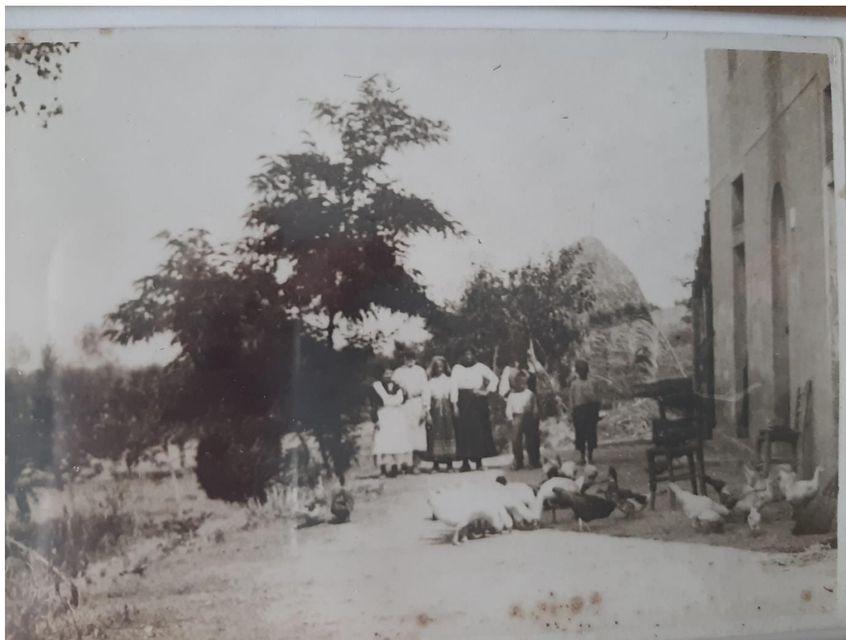
IMMAGINE RISALENTE AGLI ANNI '20 DEL NOVECENTO E SULLA SINISTRA UNA PORZIONE DEL PROSPETTO SUD-OVEST ORIGINARIO DEL FABBRICATO
