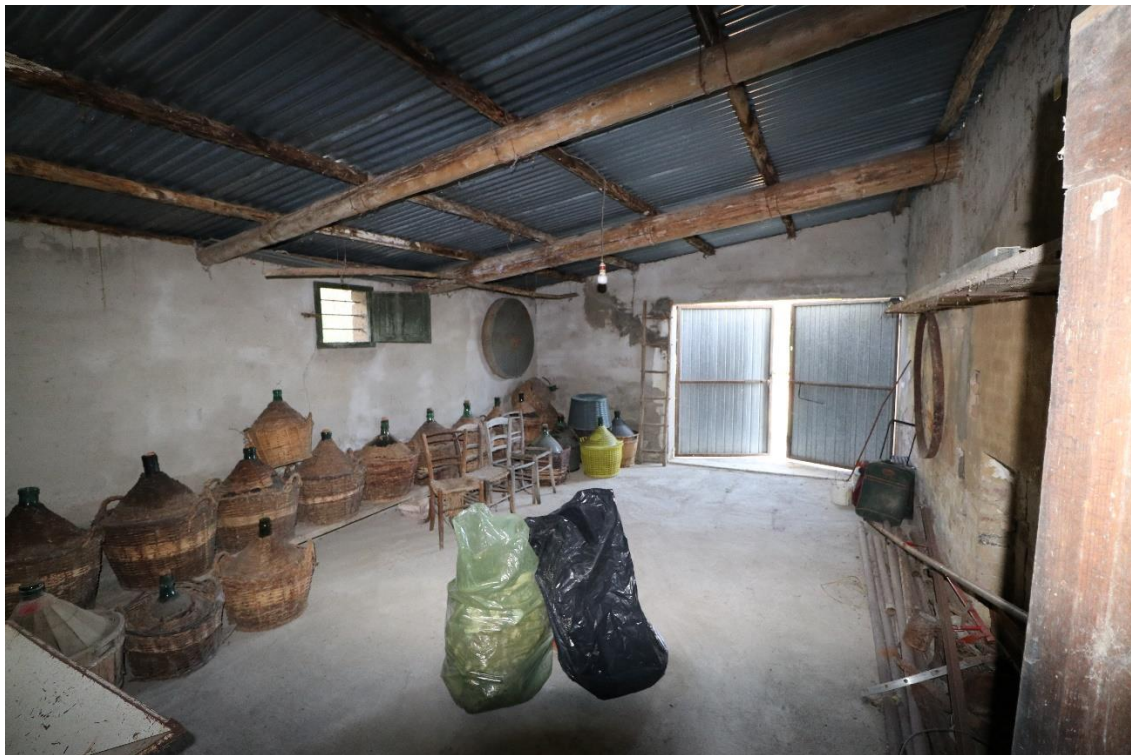
VEDUTA DELLA RIMESSA (COPERTURA E PARETI PERIMETRALI)
