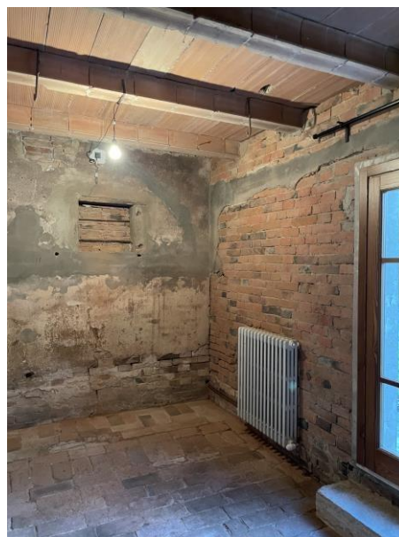
INTERNI DEL PIANO TERRA - PAVIMENTI FINITURE E DEL SOLAIO IN LATEROCEMENTO
