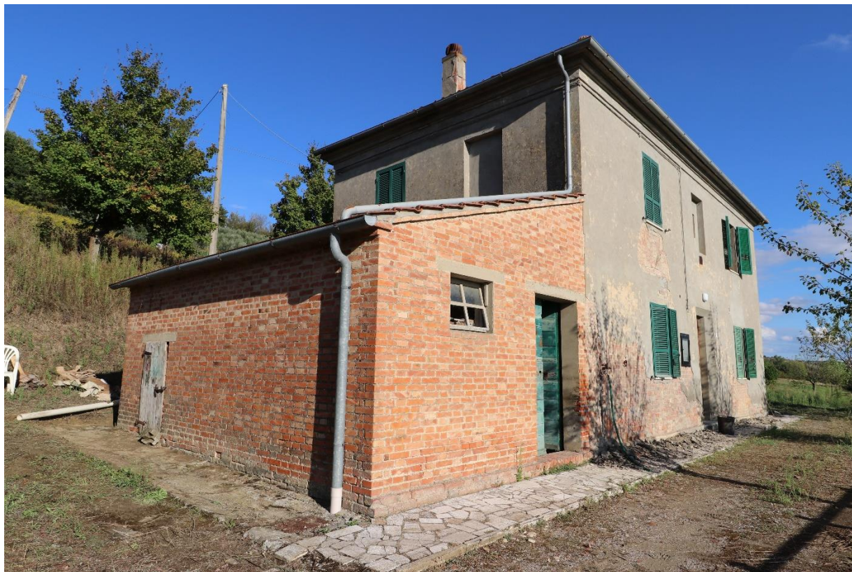
LATO SUD-OVEST - FABBRICATO PRINCIPALE E IL CORPO ANNESSO DESTINATO A CANTINA (Foto ottobre 2019)
