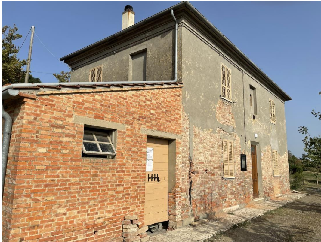
LATO SUD-OVEST - FABBRICATO PRINCIPALE ED IN PRIMO PIANO IL CORPO ANNESSO DESTINATO A CANTINA
