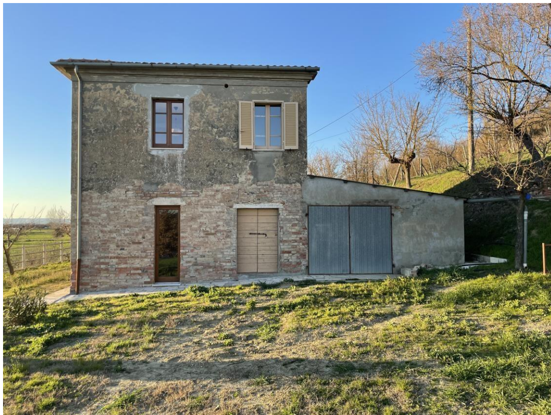
LATO SUD-EST - FABBRICATO PRINCIPALE E SULLA DESTRA IL CORPO ANNESSO DESTINATO A RIMESSA
