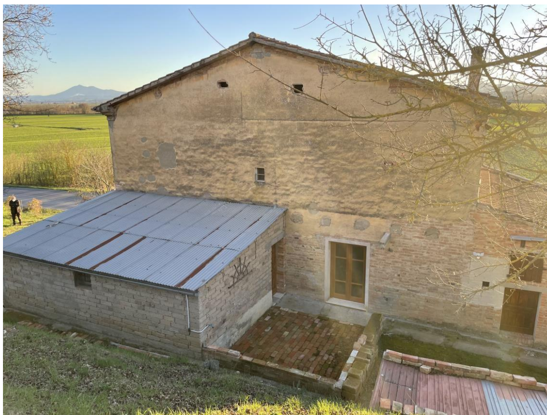
LATO NORD-EST - FABBRICATO PRINCIPALE ED IN PRIMO PIANO IL CORPO ANNESSO DESTINATO A GARAGE DELIMITATO DA PARETI IN TUFO
