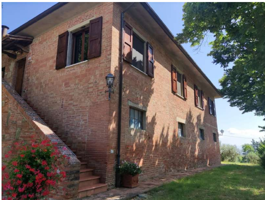
Figura 10 - Vista angolo Sud - Est
