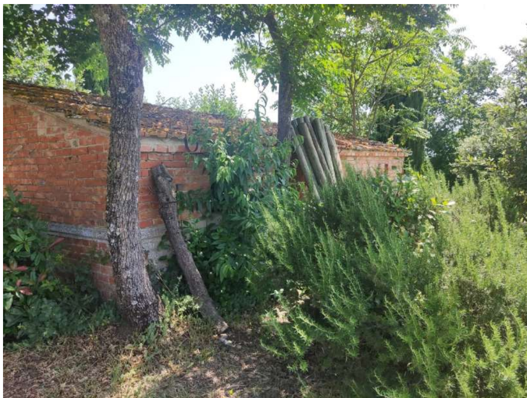
Figura 21 - Vista Nord - Ovest
