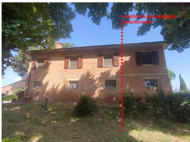
Figura 7 – foto con individuazione delle cesure tra il volume principale e successivi ampliamenti.
