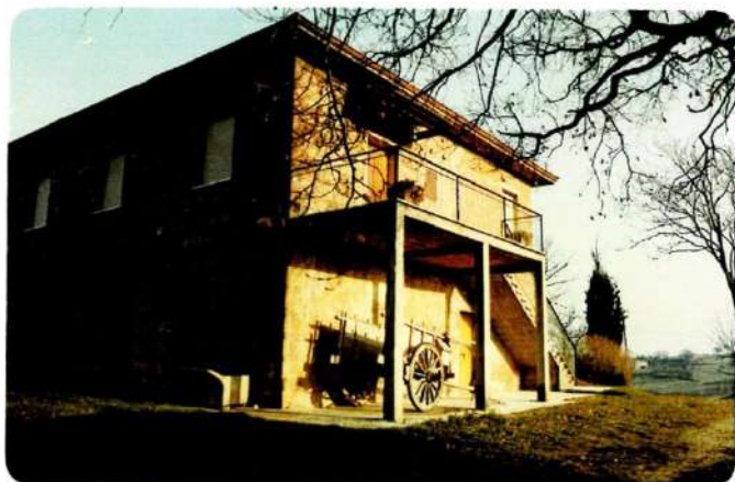
Figura 8 – foto storiche allegata alla pratica 382/93 che mostrano il portico ad uno stato precedente l'intervento di rivestimento
