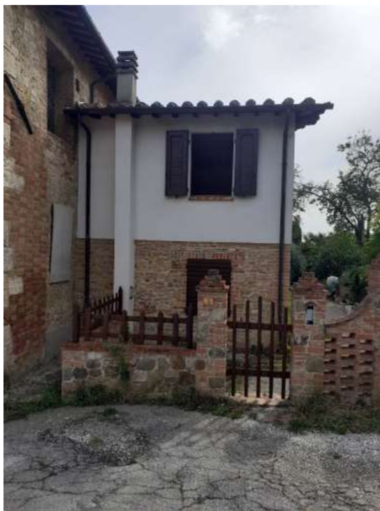
FOTO 1 – Veduta del fabbricato da Via degli Olivi.-
