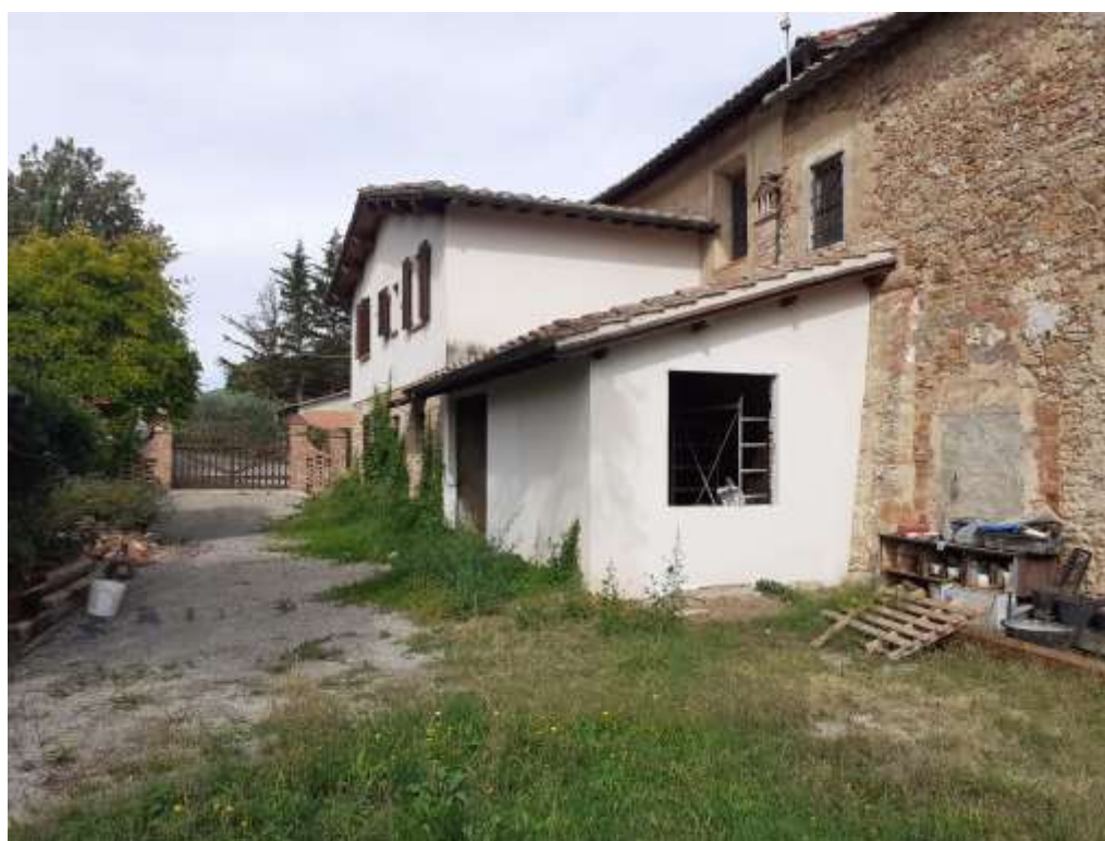
FOTO 3 – Veduta del fabbricato dal resede.-
