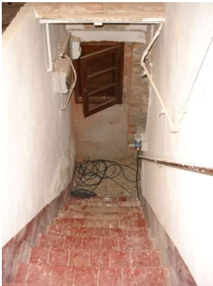
FOTO 13, 14 – Veduta degli interni.-
