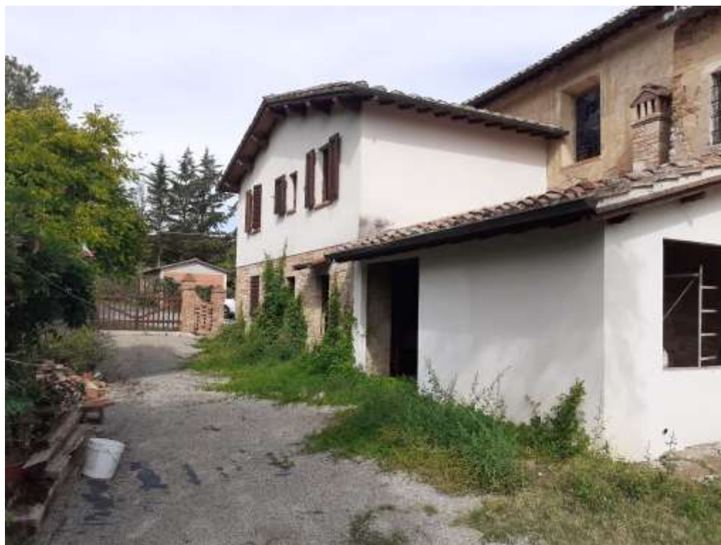
FOTO 4 – Veduta del fabbricato dal resede.-
