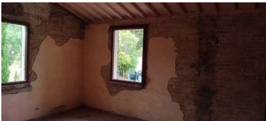
FOTO 7, 8, 9 – Veduta degli interni.-
