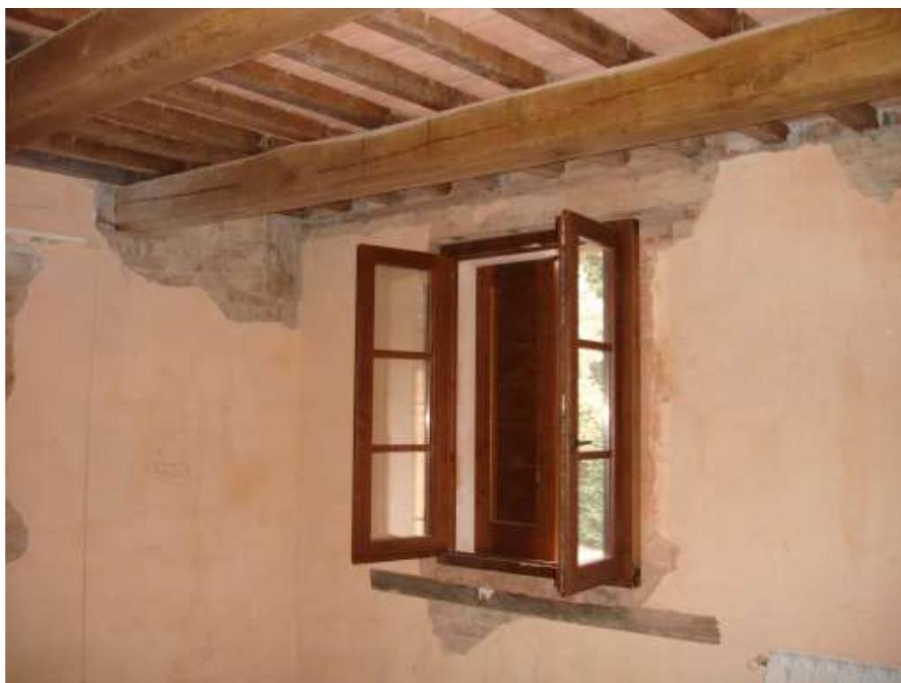
FOTO 11, 12 – Veduta degli interni.-
