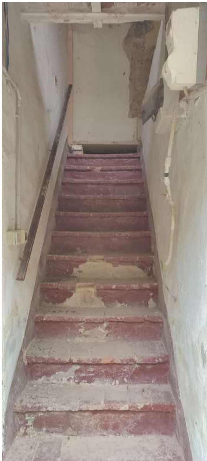
FOTO 6 – Veduta della scala interna.-
