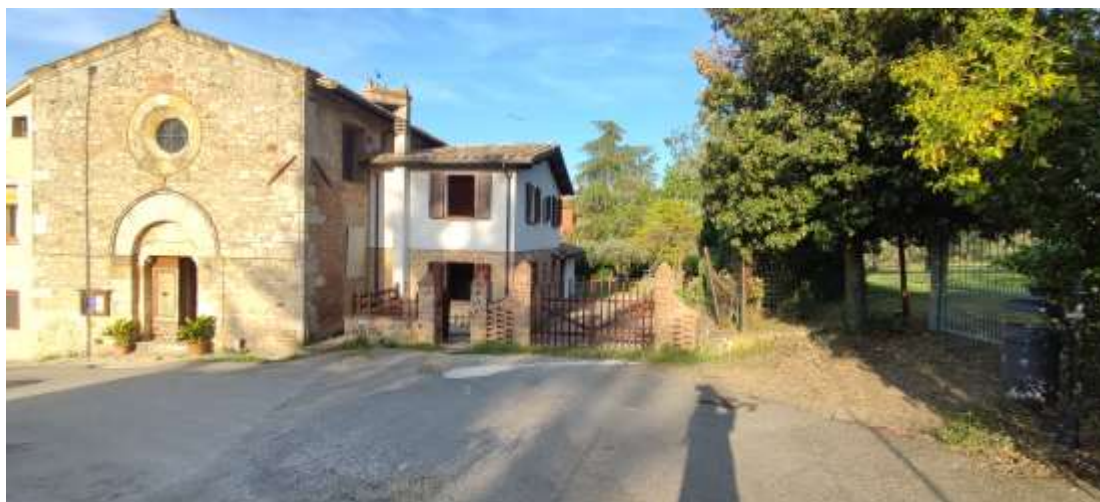
FOTO 5 – Veduta del fabbricato dal fronte.-
