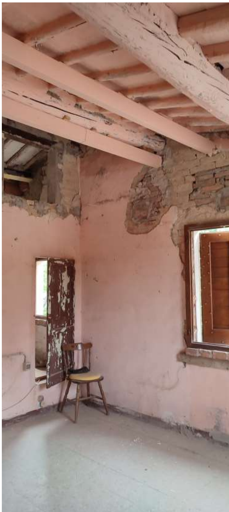
FOTO 10 – Veduta degli interni.-
