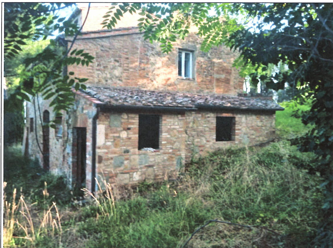
PARTICOLARE RAVVICINATO DEL PROSPETTO LATO SINISTRO E RETRO
