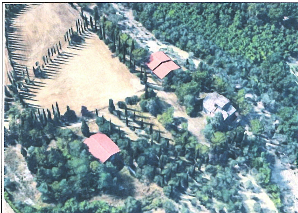
FOTO AEREA (si evidenzia dall'alto verso il basso: Annesso 1; Fabbricato Principale; Annesso 2)
