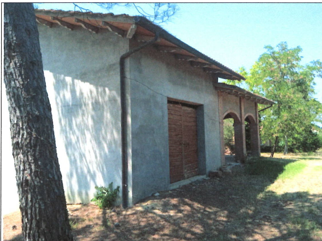
PARTICOLARE RAVVICINATO LATO FRONTALE E LATO SINISTRO DELL'ANNESSO
