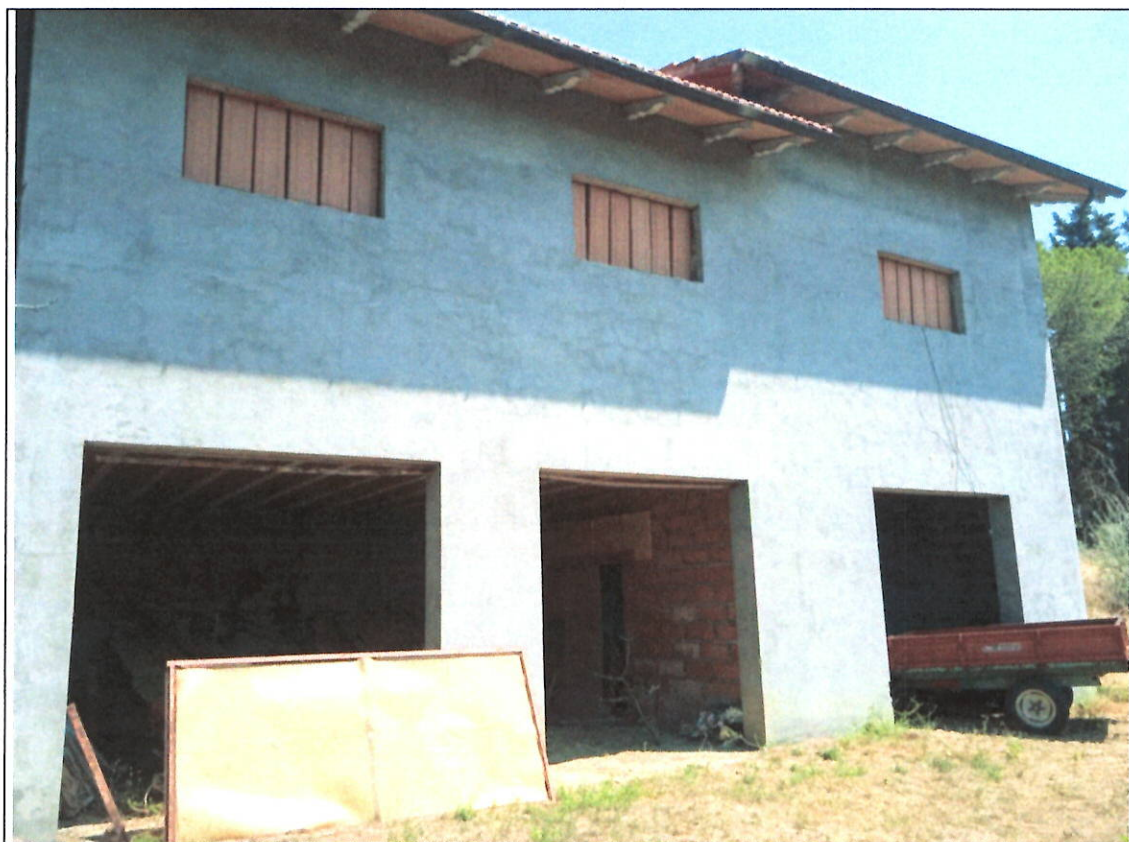
PARTICOLARE DELL'ANNESSO 1, - LATO A VALLE
