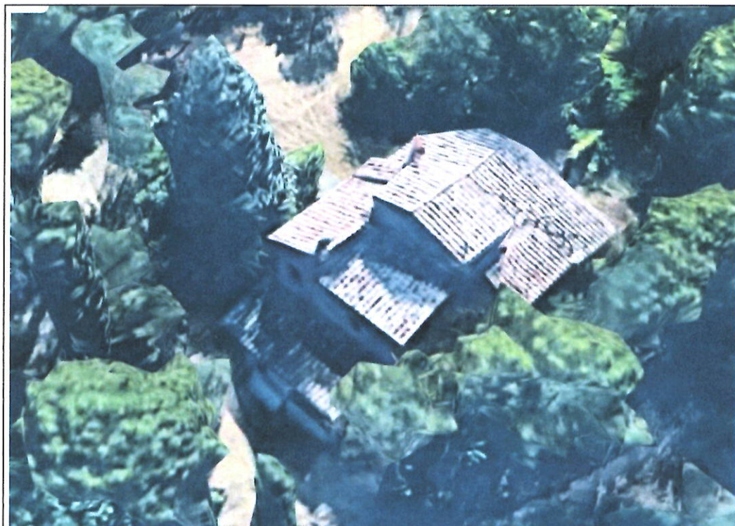
Particolare aereo del fabbricato principale
