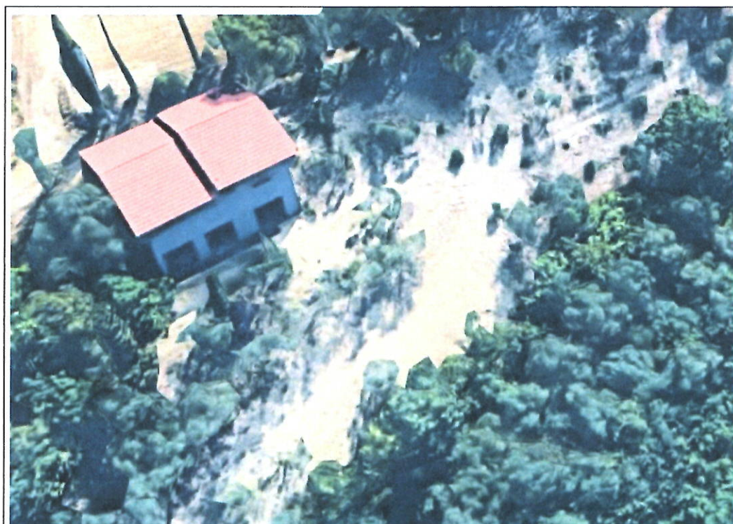
PARTICOLARE AEREO DELL'ANNESSO N°1
