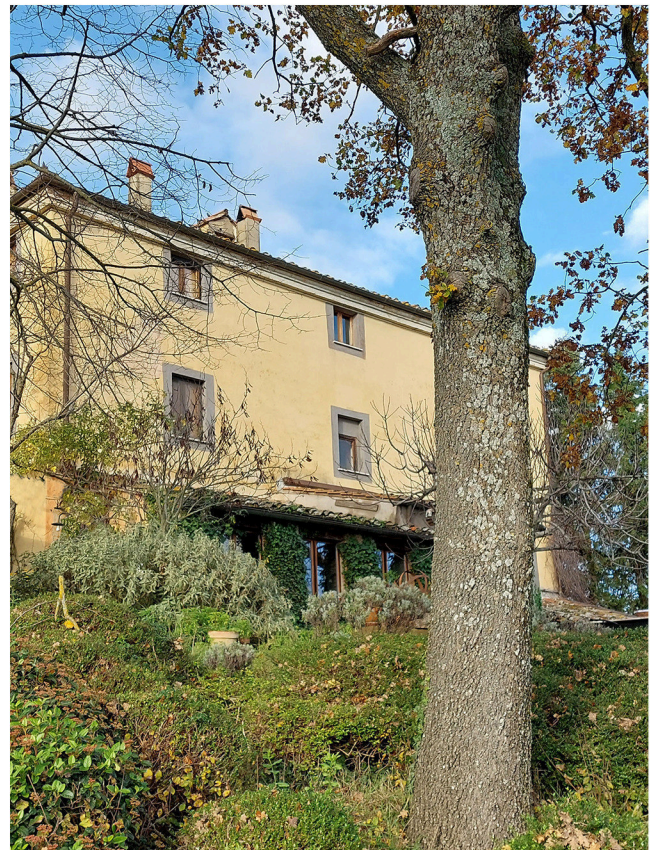
Foto 2- Corpo 1 in aderenza a fabbricato principale
