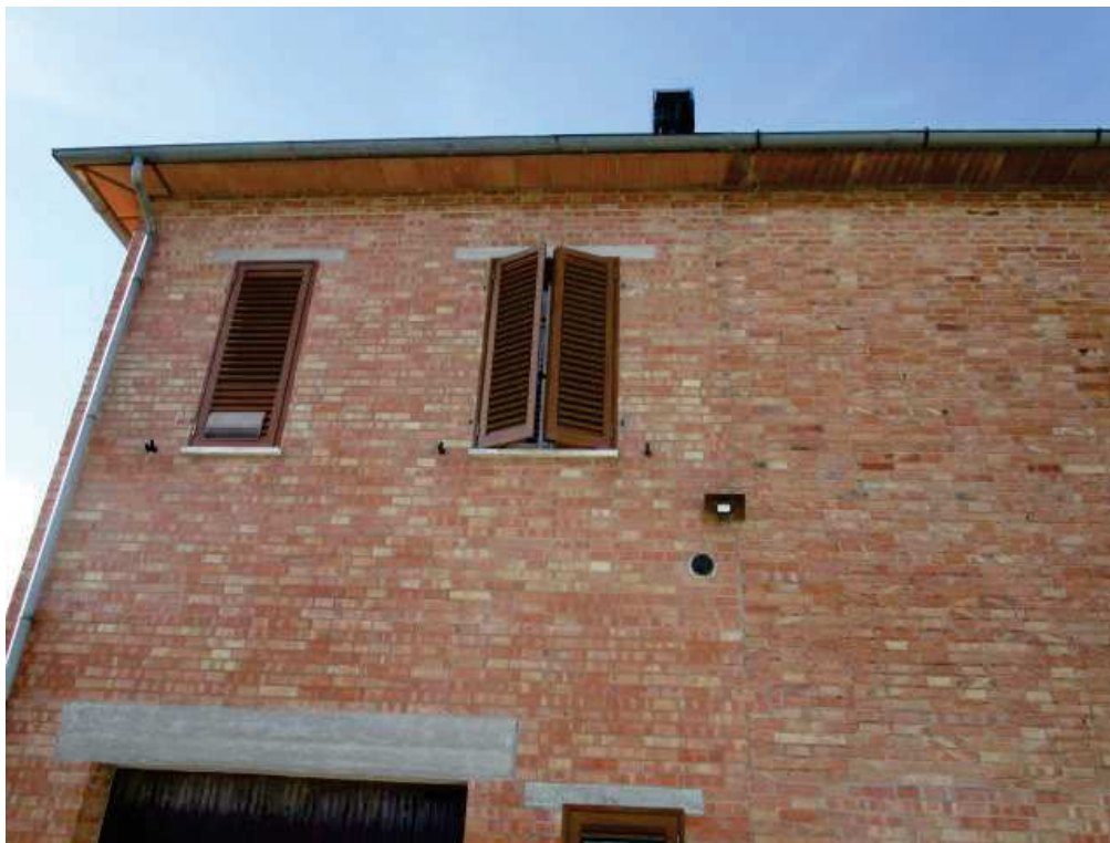
Particolare tessiture murarie porzione esistente e porzione realizzata negli anni 1980 con particolare della gronda
