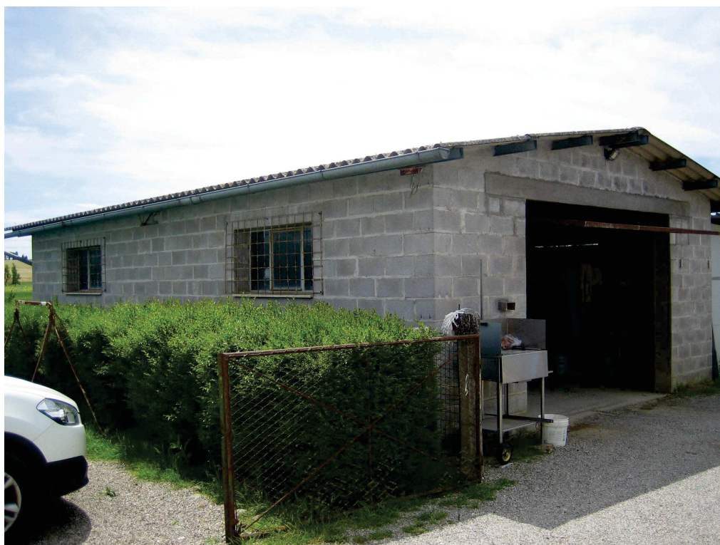
Edificio pertinenziale n. 1
