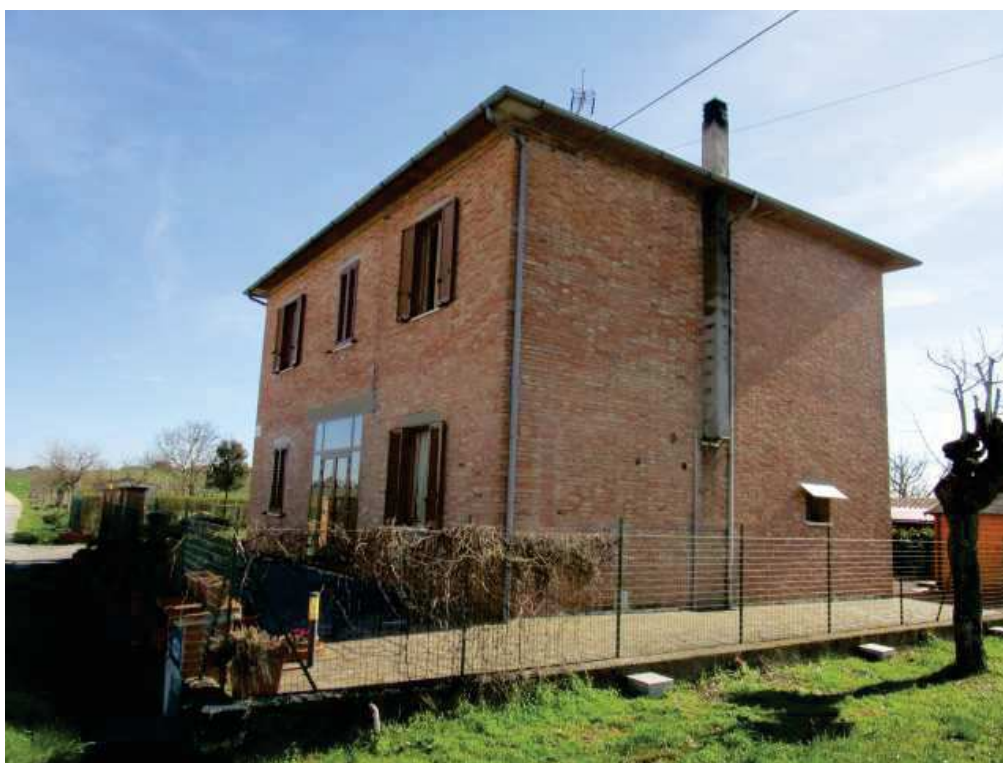
Fronte e lato destro
