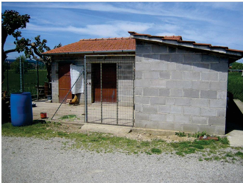
Edificio pertinenziale n. 2
