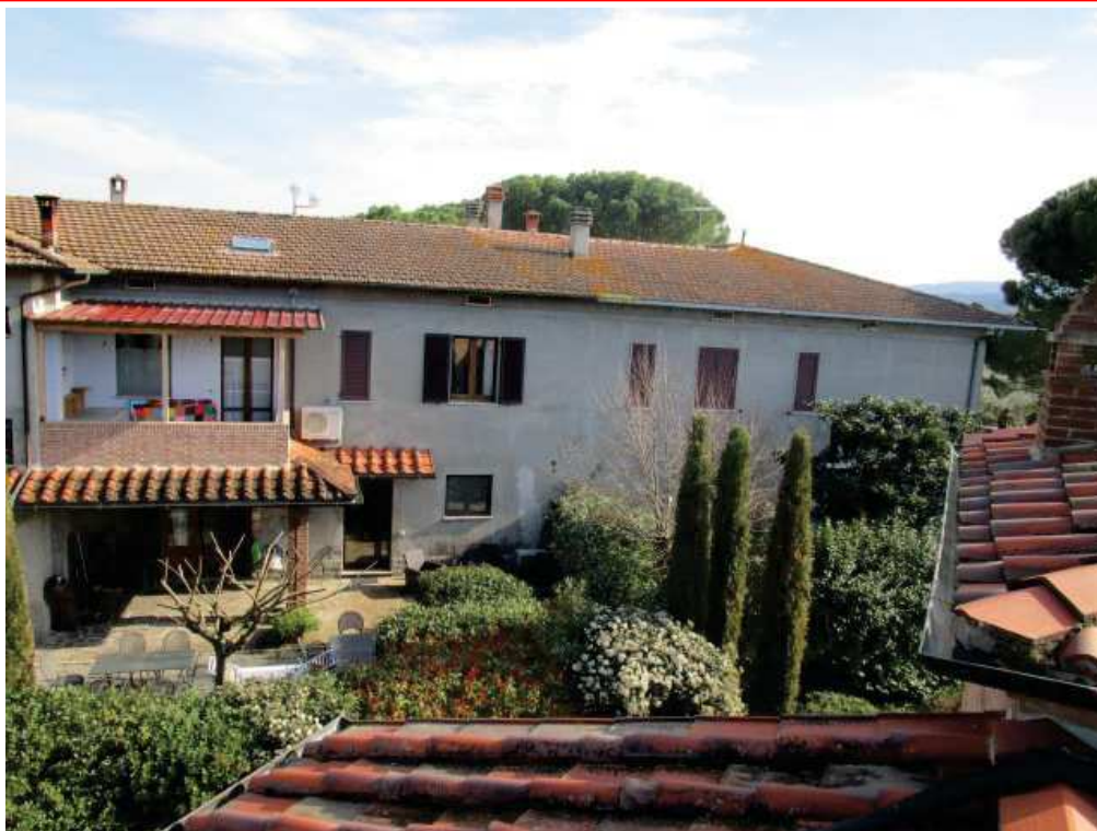
Vista del prospetto nord-ovest (2° parte – altra proprietà)
