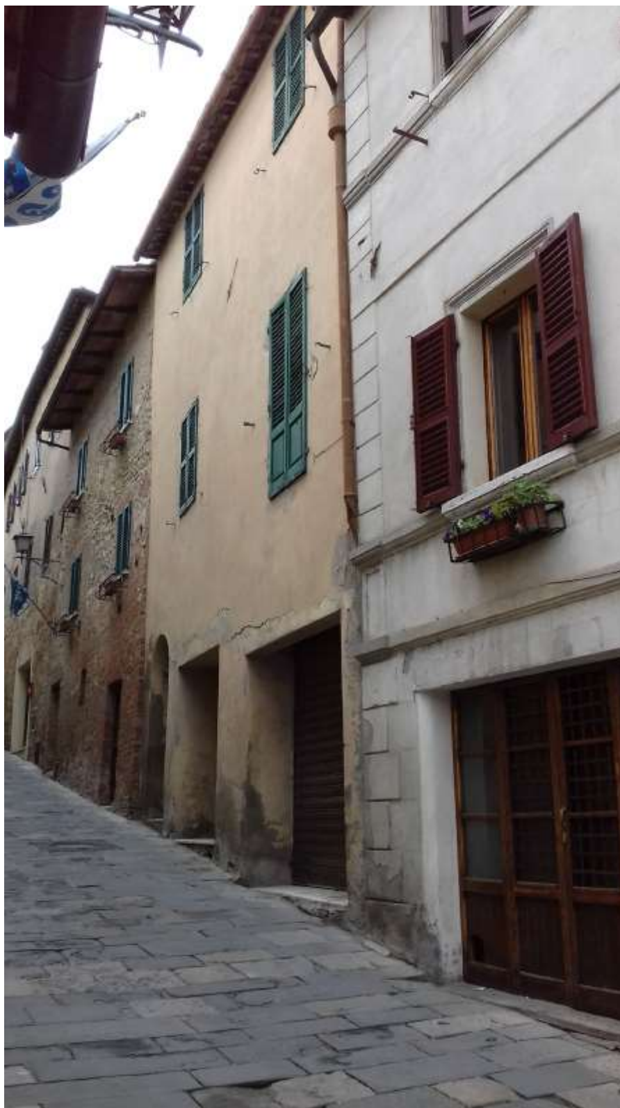
FOTO 4 – Veduta del fabbricato da Via del Poggiolo.-
