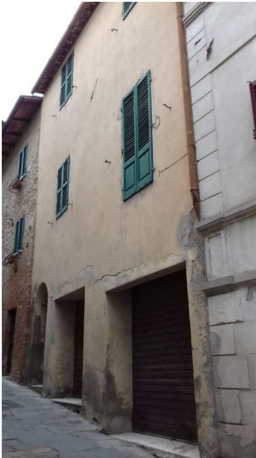
FOTO 3 – Veduta del fabbricato da Via del Poggiolo.-
