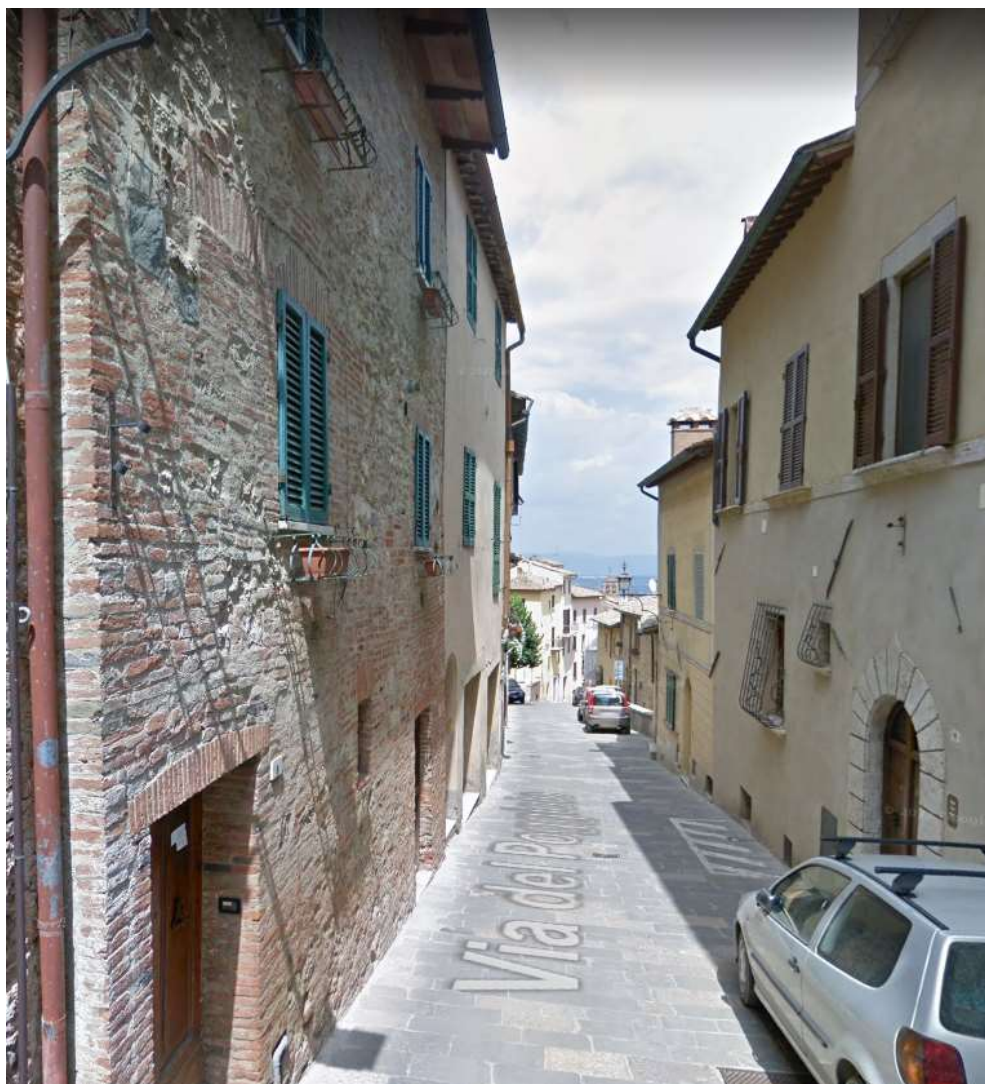
FOTO 2 – Veduta del fabbricato da Via del Poggiolo.-
