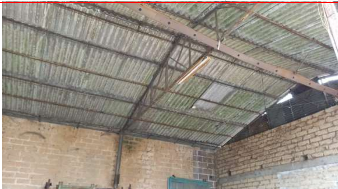
FOTO 7 – Veduta del capannone.-
