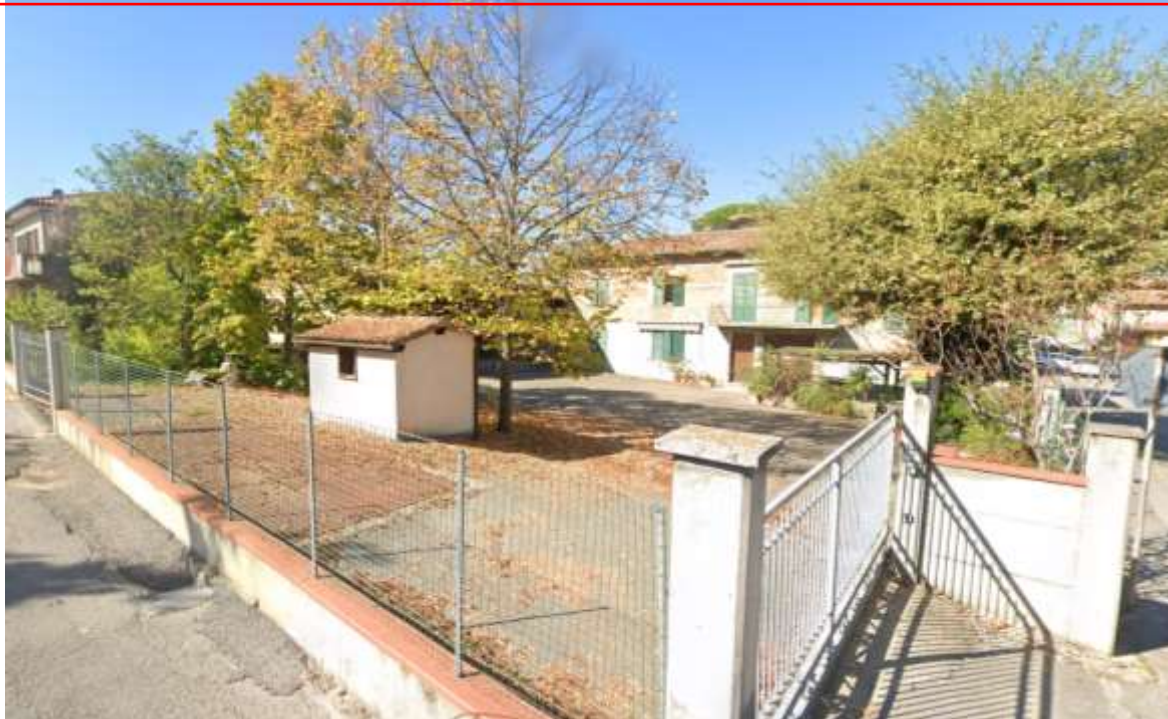
FOTO 1 – Veduta del fabbricato residenziale.-
