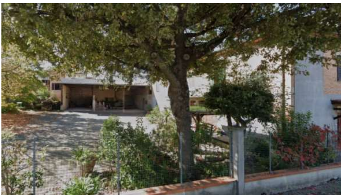
FOTO 4 – Veduta del capannone.-
