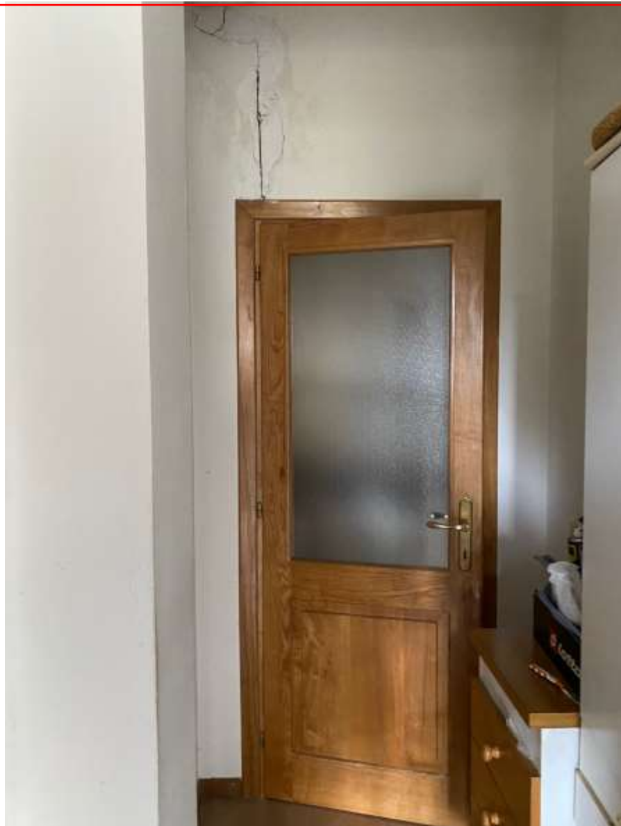
FOTO 11 – Veduta degli interni.-
