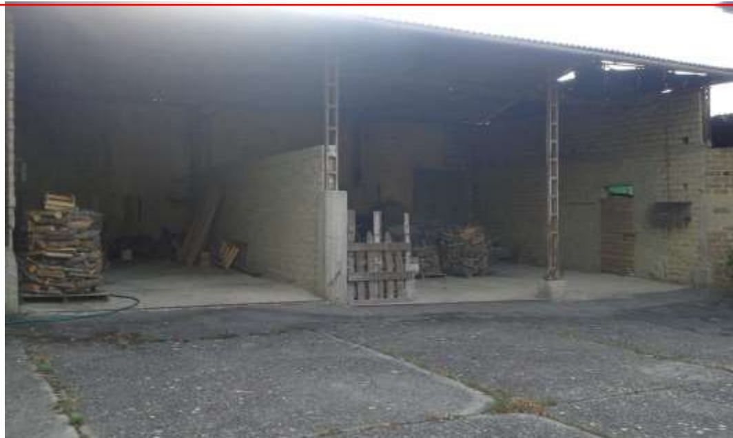
FOTO 9 – Veduta del capannone.-
