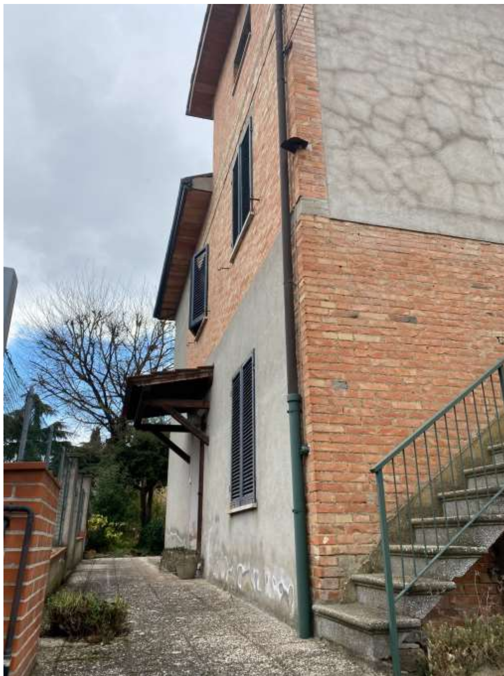
FOTO 5 – Veduta dell'accesso su Via Bergamo.-
