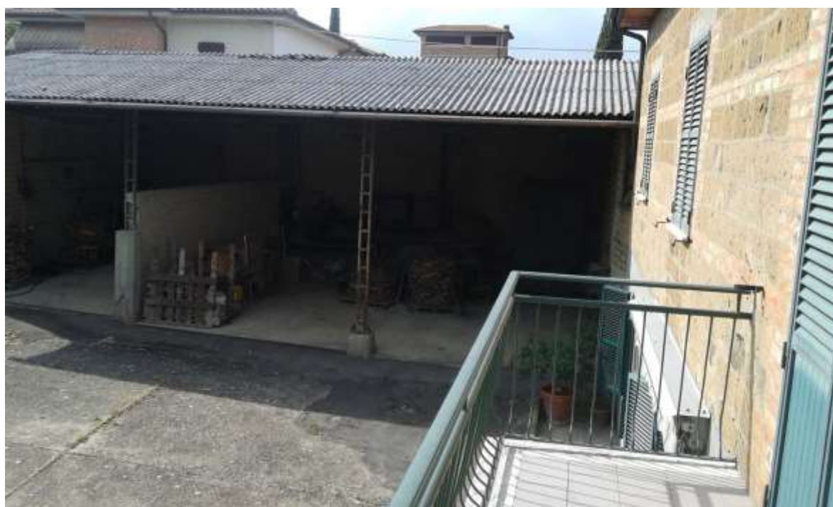
FOTO 8 – Veduta del capannone.-
