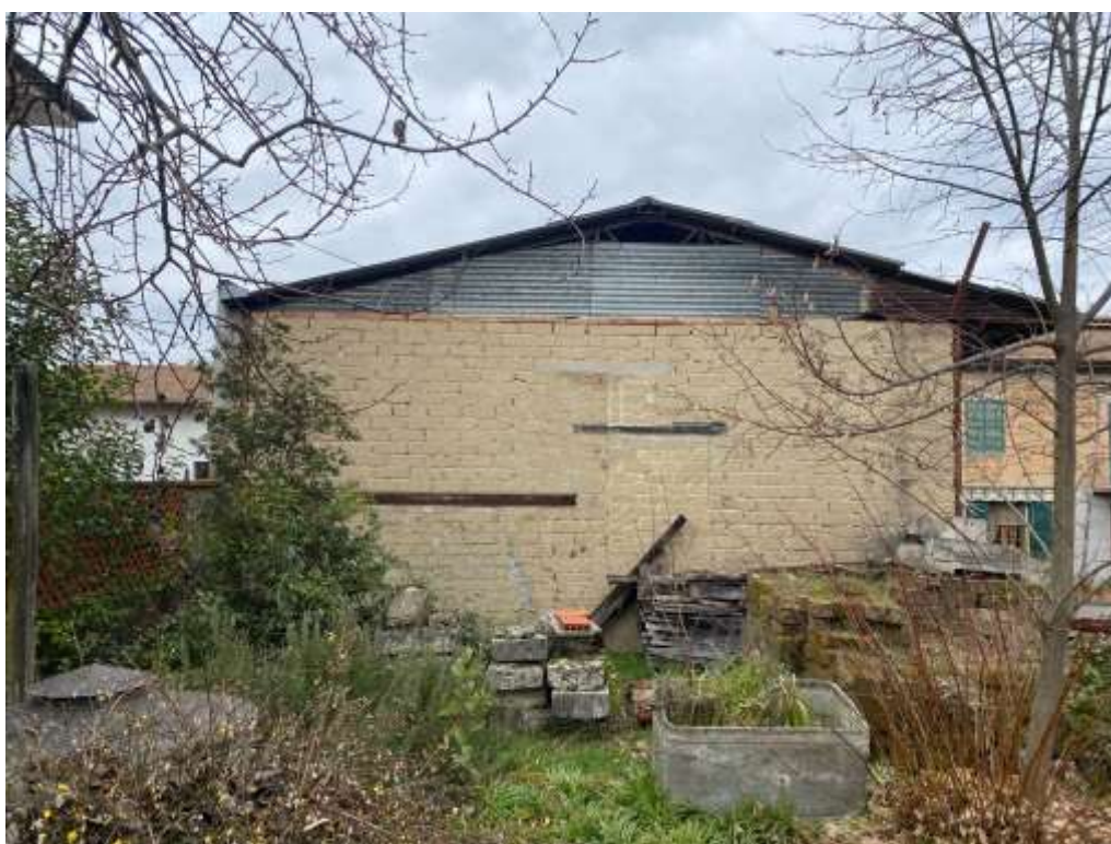
FOTO 2 – Veduta del capannone.-
