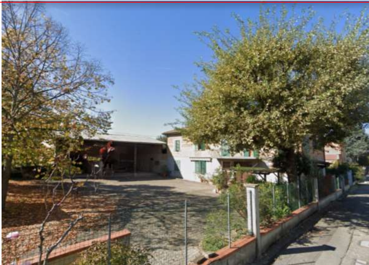
FOTO 3 – Veduta del capannone e della casa.-
