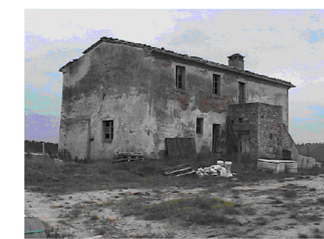
Foto n. 3 - Fronte e lato sinistro
