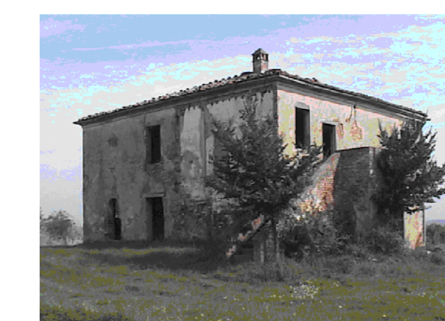
Foto n. 2 - Fronte e lato sinistro
