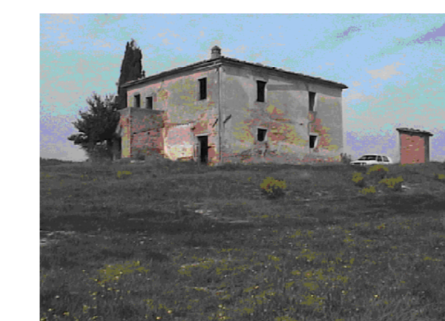
Foto n. 6 - Lato destro e fronte
