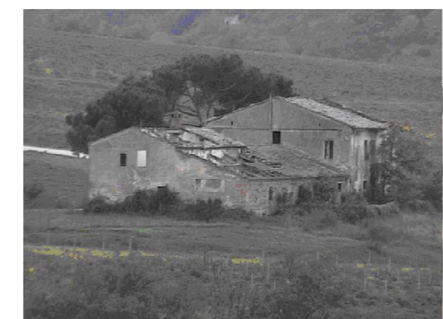
Foto n. 4 - Retro e lato destro
