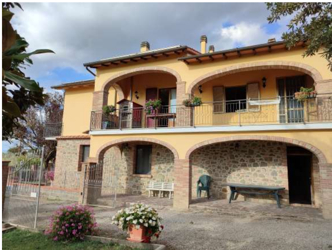
FOTO 7 - Vista dal resede.-
