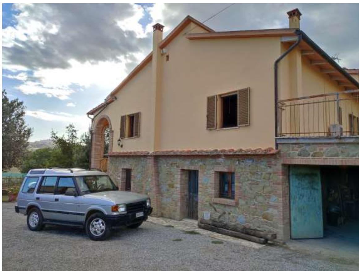
FOTO 8 - Vista dal resede.-
