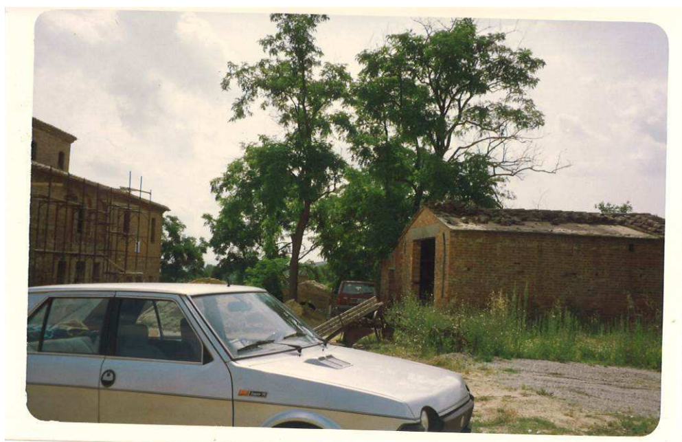
Fase di cantiere (1993) – viene smantellato il manto di copertura
