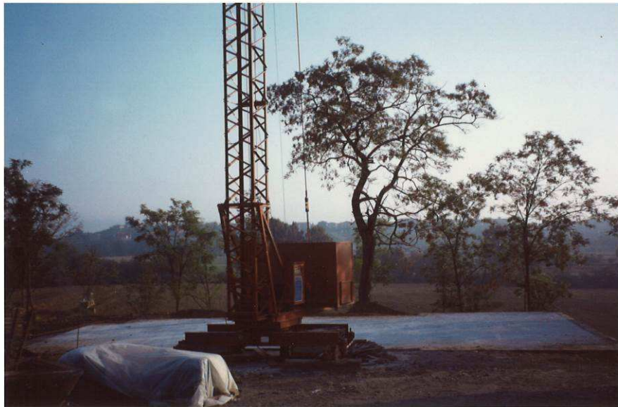
Fase di cantiere – al posto del magazzino e dello stallino è stata eseguita la platea per la successiva edificazione della nuova struttura (1993)
