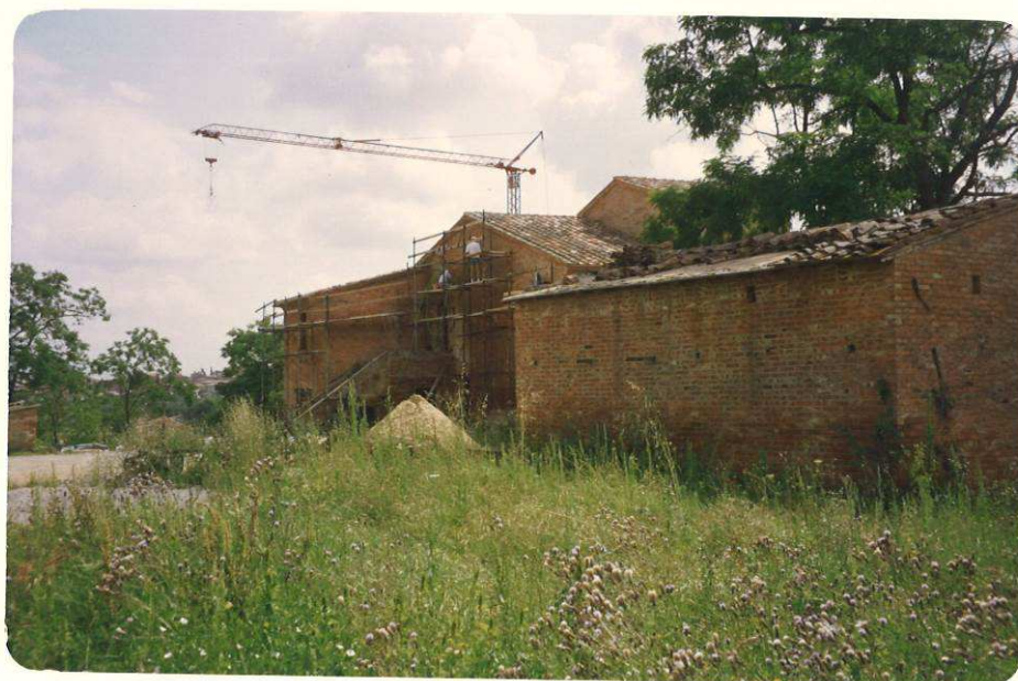
Fase di cantiere (1993) – viene smantellato il manto di copertura
