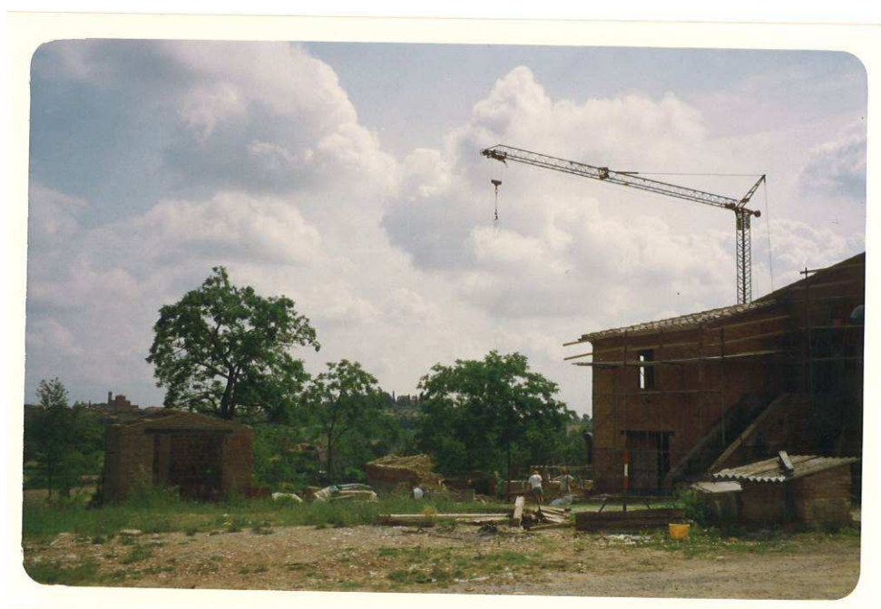
Prima fase di cantiere (1993) – magazzino e stallino in fase di demolizione
