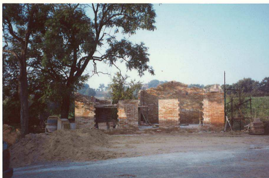
Fase di cantiere (1993) – demolizione
