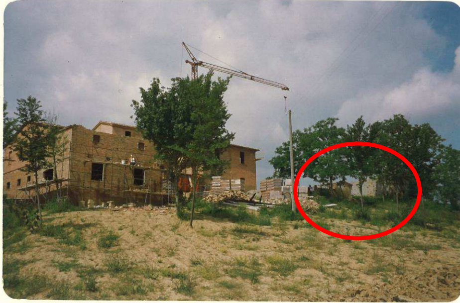
Fase di cantiere – magazzino e stallino in demolizione (1993)
