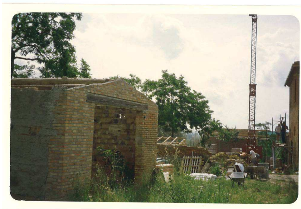
magazzino e stallino in fase di demolizione (1993)
