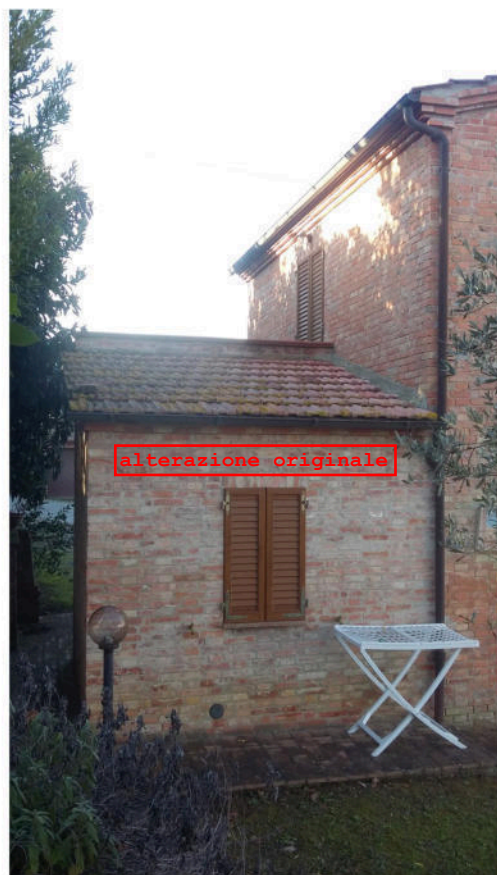
Foto 8 - FABBRICATO 2 - Retro e lato destro
