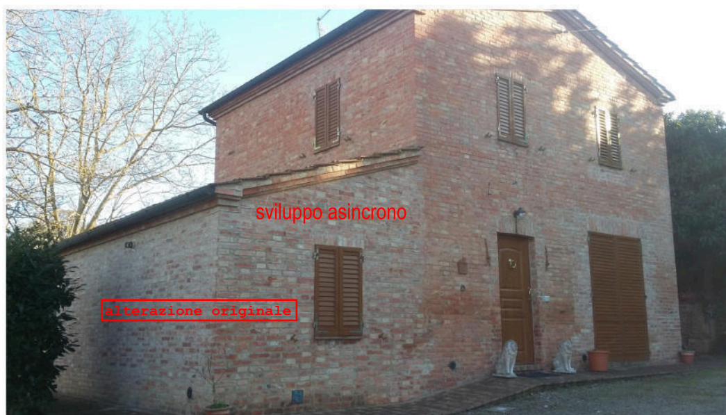
Foto 6 - FABBRICATO 2 - Fronte e lato sinistro
