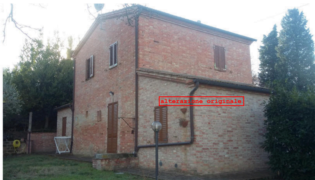
Foto 7 - FABBRICATO 2 - Lato sinistro e retro
