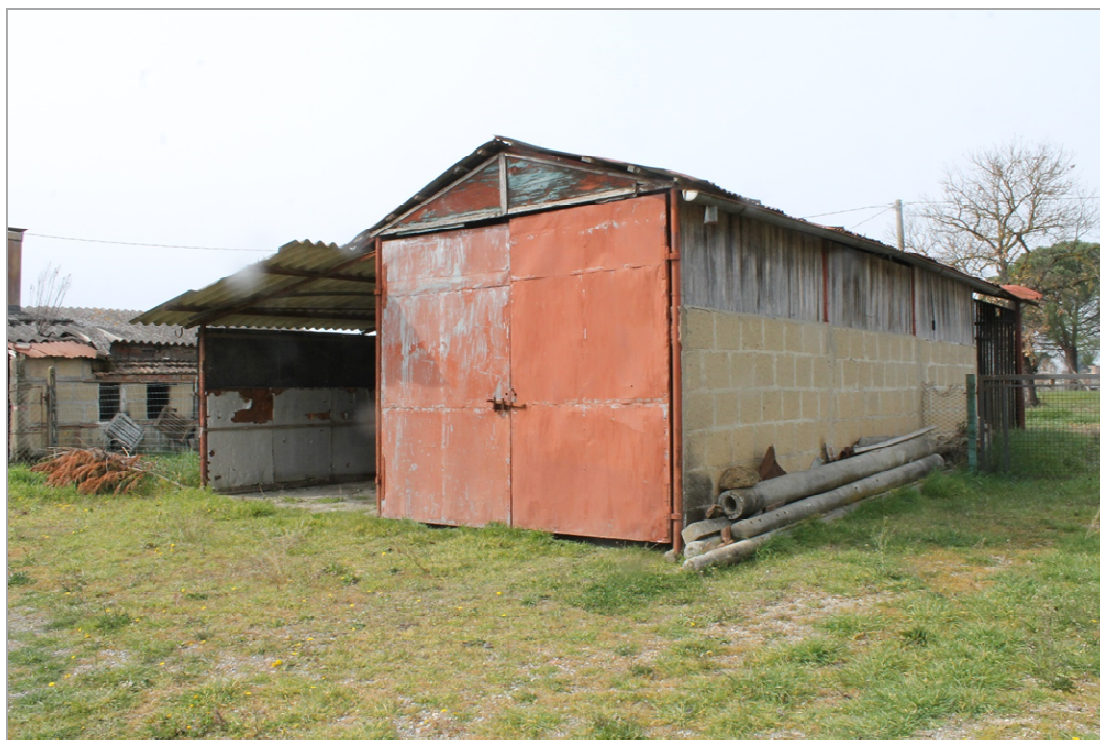
Foto 5 – Annesso pertinenziale (identificato in Estratto di Mappa Catastale con il n. 3) Come si evince dalla foto l'annesso pertinenziale ha valore documentale nullo, poiché ex edificio strumentale all'attività agricola e tipologicamente incongruo con il contesto poiché realizzato con materiali inadeguati per il contesto in cui è posto (strutture in ferro, coperture in lamiera ondulata, strutture in blocchi di cemento e/o laterizio faccia vista).
