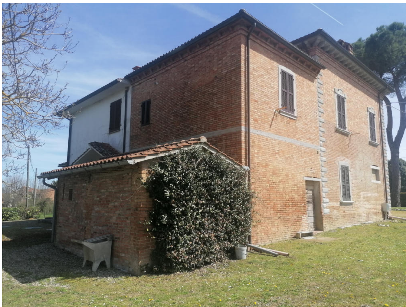
Foto n. 2 – Vista del lato destro e retro
