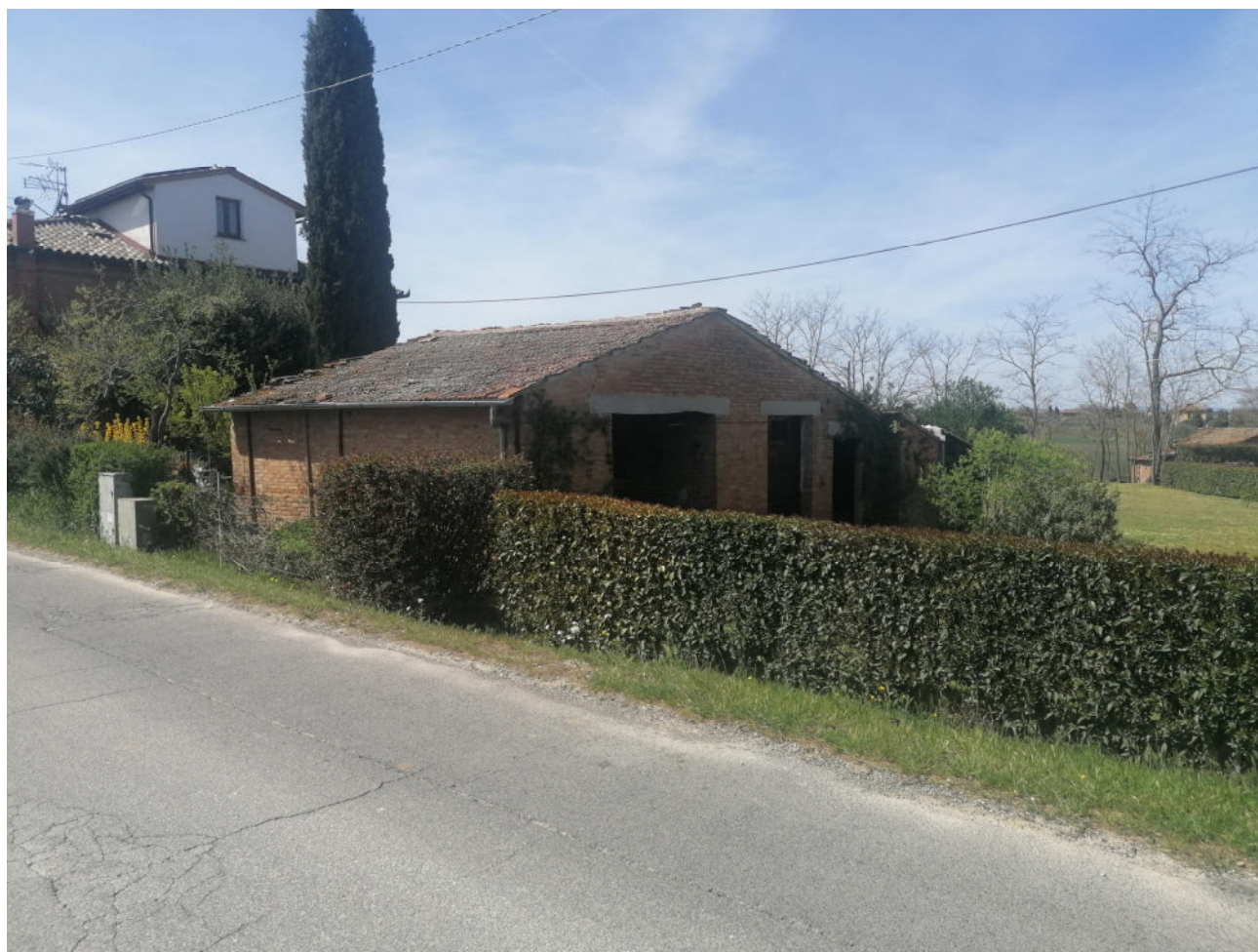
Foto n. 4 – Vista del lato sinistro e fronte
