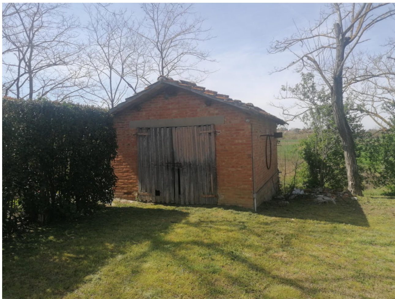
Foto n. 1 – Vista del fronte e del lato destro
