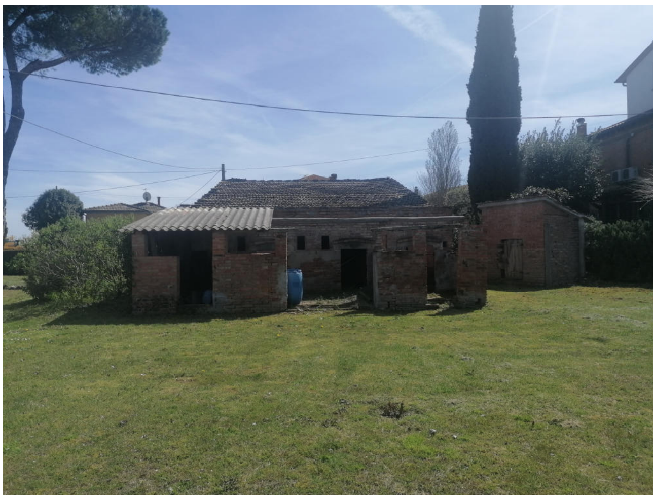
Foto n. 2 – Vista del lato destro
