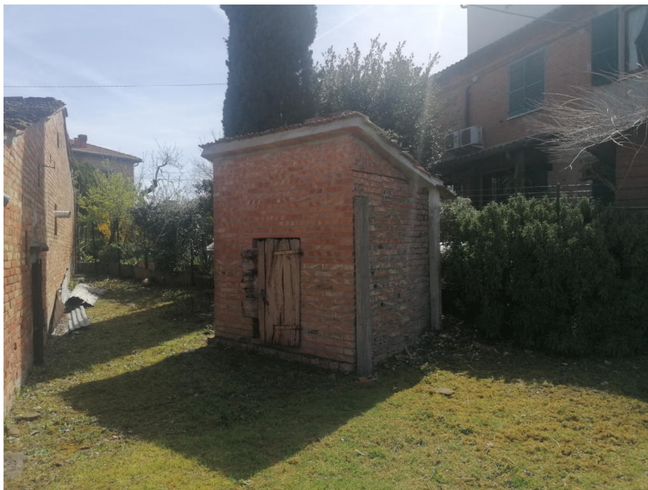
Foto n. 1 – Vista del fronte e lato destro
