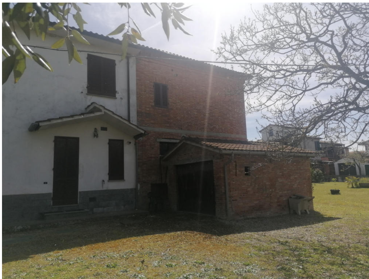
Foto n. 1 – Vista del fronte e lato destro
