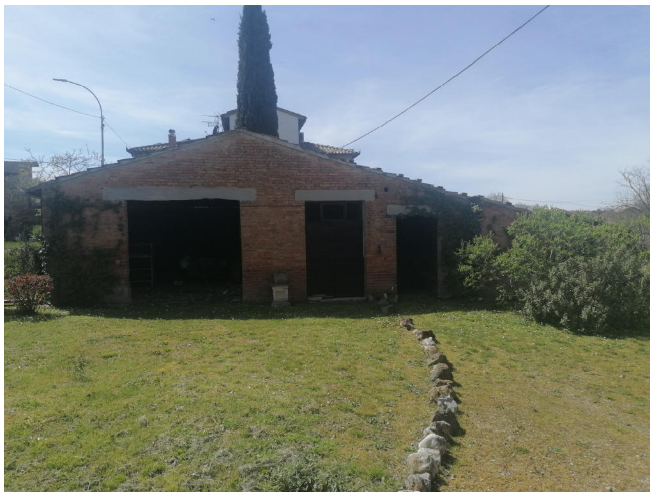
Foto n. 1 – Vista del fronte
